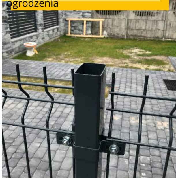
Brak kapturka słupka ogrodzenia
