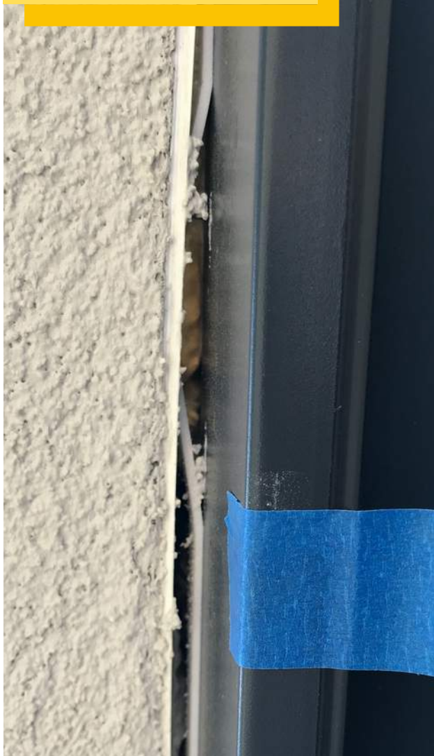
Nieprzylegająca listwa APU
