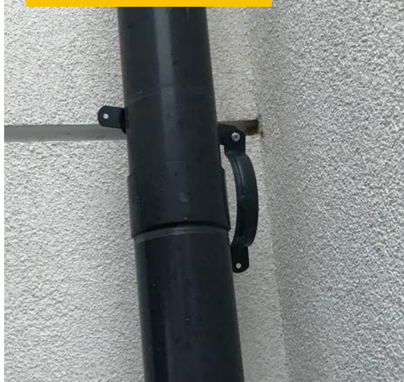
Nieprzykręcona rura spustowa rynny
