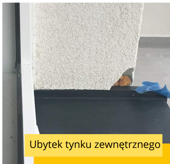
Odparzony tynk zewnętrzny
